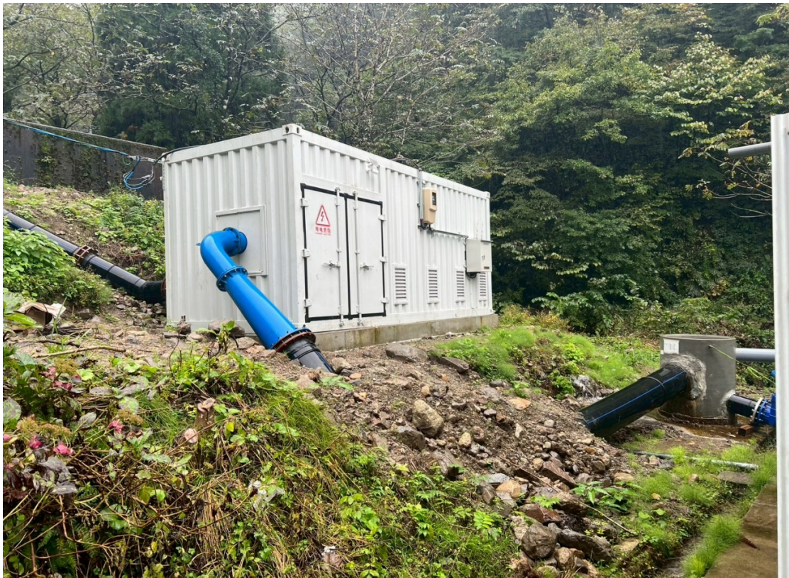
発電設備 発電に使用した水は全量河川に戻しますが、 河川と用水に分けて戻すことも可能
