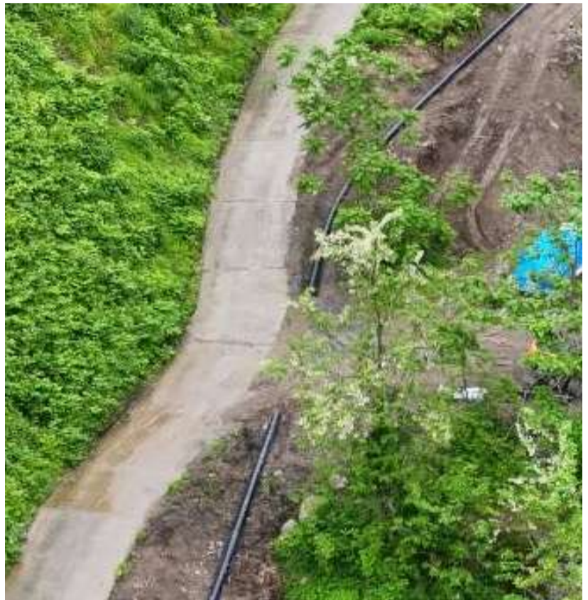
道路を横断する場合は埋設
